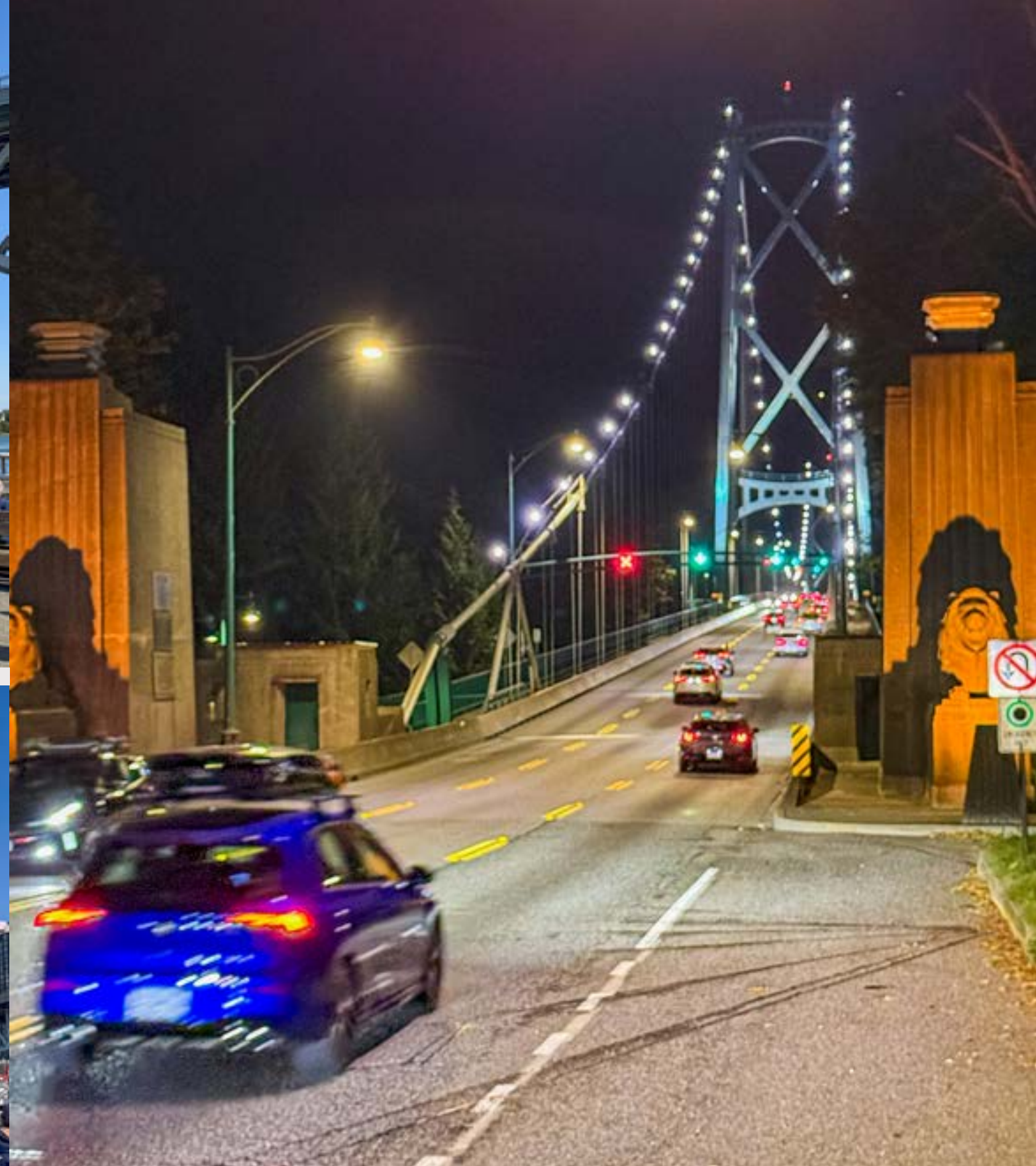
Links oben: Bild 293: Granville Island und Granville Bridge Links unten: Bild 294: Mini-Fähren und Blick auf Downtown Oben: Bild 295: Rückfahrt über die Lions Gate Bridge
